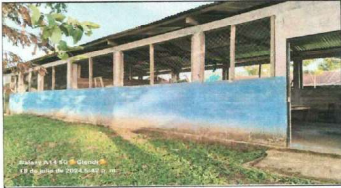
Foto 2: Estructura y cubierta de techo en el patio
