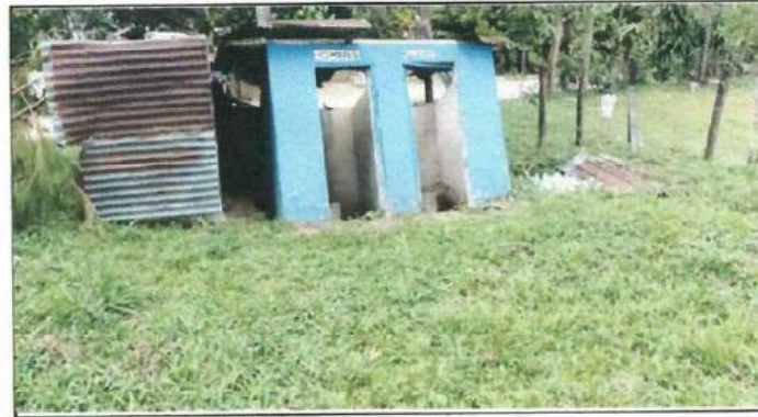
Foto 4: Reparacion de baños
