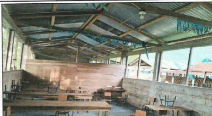
Foto1: Cambio de te cubierta y estructura de techo
